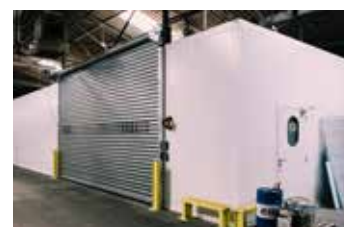
Ligne de fabrication des panneaux sandwich
