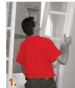
1. Dégondage des ouvrants.
