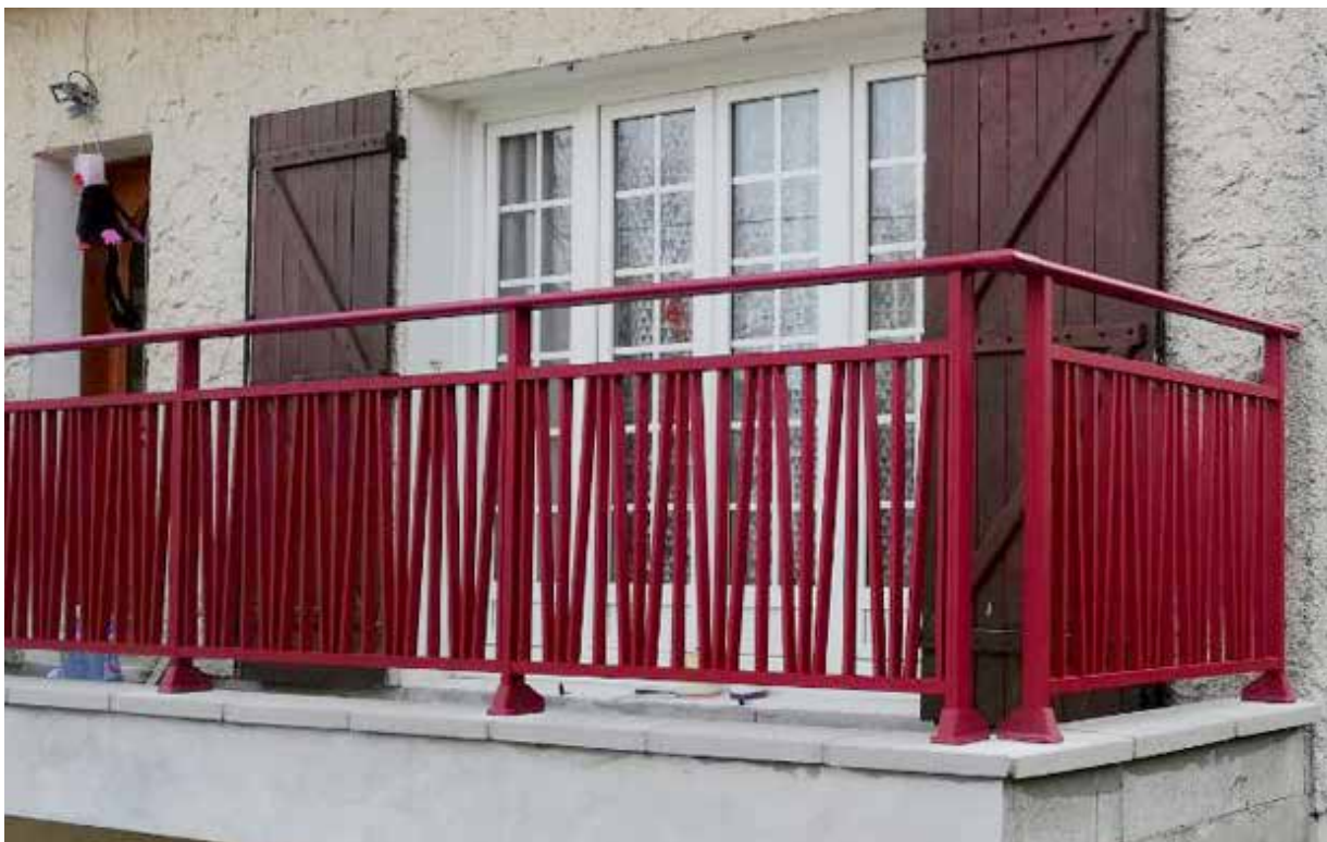
Briel Lisses verticales 15 mm obliques avec vide sous main-courante. ∨ Pose sur dalle.
