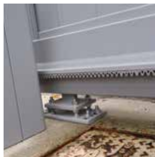
< 1 Monture avec galet de guidage
