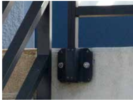
Fri Pose en nez de dalle ou fixation à l'anglaise
